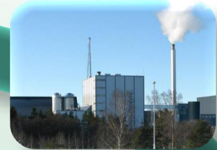
Sähkön ja lämmön yhteistuotantolaitos
